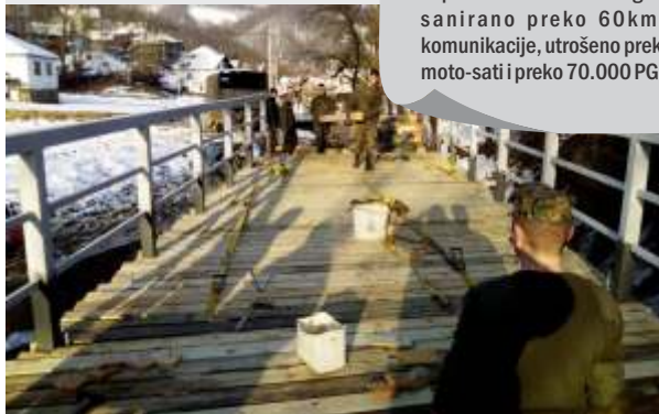
OS BiH izvršile sanaciju mosta u općini Doboj-Istok, 16.02.2015.
